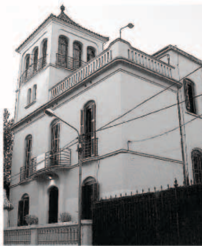
L'edifici de l'Ateneu Municipal, al carrer de Xile. ARQU
